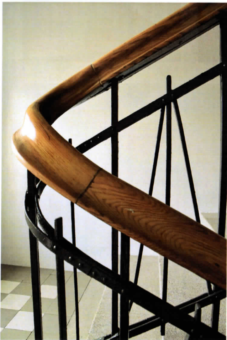
Fot. 1. Nitowana konstrukcja żeliwnej balustrady klatki schodowej, drewniana profilowana poręcz
