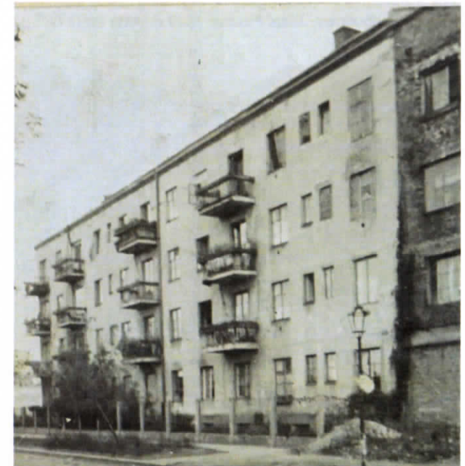
Fot. 8. Elewacja zachodnia (przy ul. Podchorążych) - dokumentacja stanu budynku z 23.10.1947 r.
