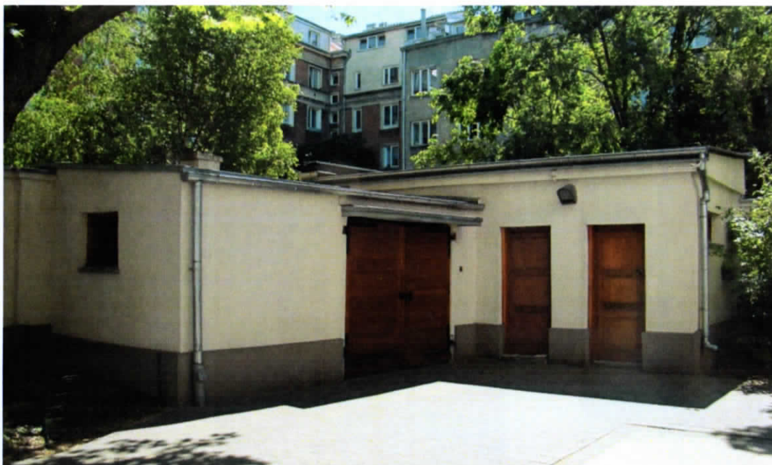
Fot. 9. Budynek gospodarczy w południowo-wschodnim narożniku posesji, wybudowany w 1958 r.
