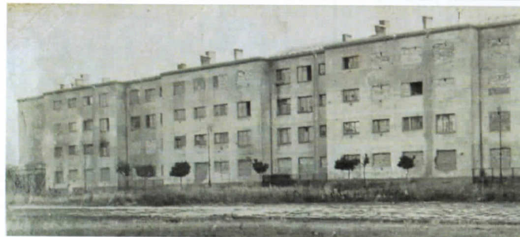
Fot. 2. Elewacja północna (przy ul. Hołówki), część wschodnia (dokumentacja stanu budynku z 23.10.1947 r.)
