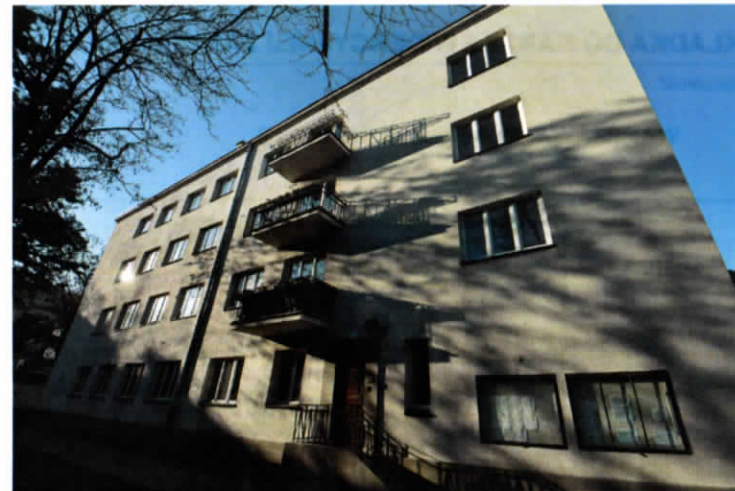
Fot. 9. Elewacja wschodnia skrzydła z klatką schodową I, widok wejścia do mieszkania dozorczy
