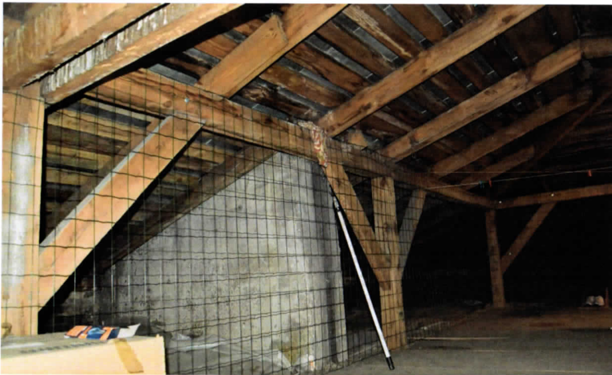
Fot. 10. Więźba nad klatką schodową nr II
