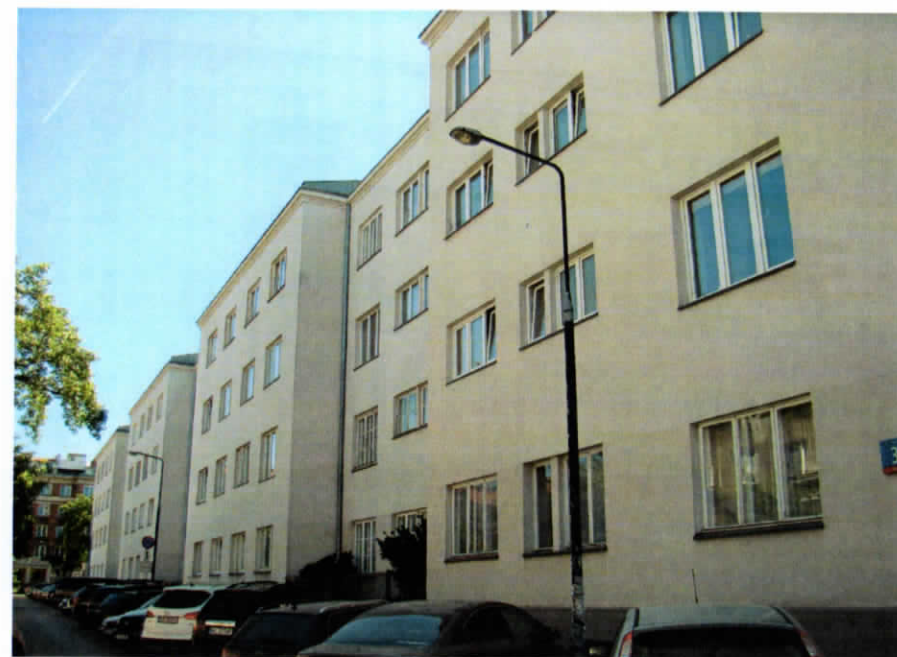
Fot. 4. Elewacja północna (przy ul. Hołówki), widok od strony zachodniej
