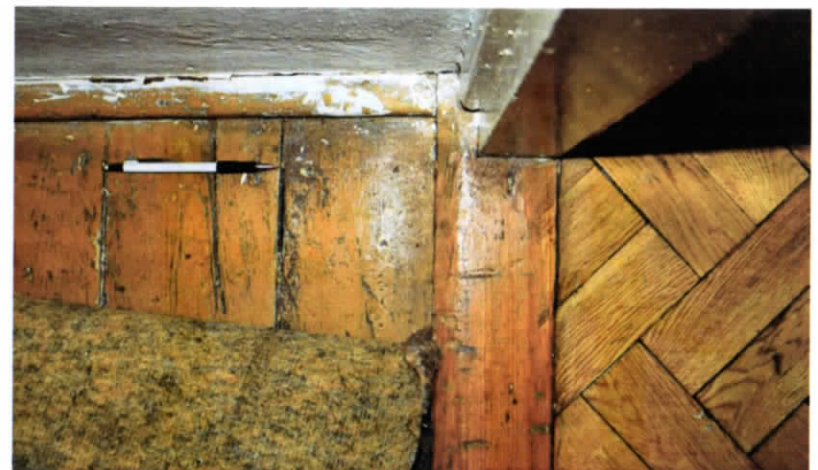
Fot. 11. Podłoga z desek i parkiet ułożony na deskach w mieszkaniu nr 64
