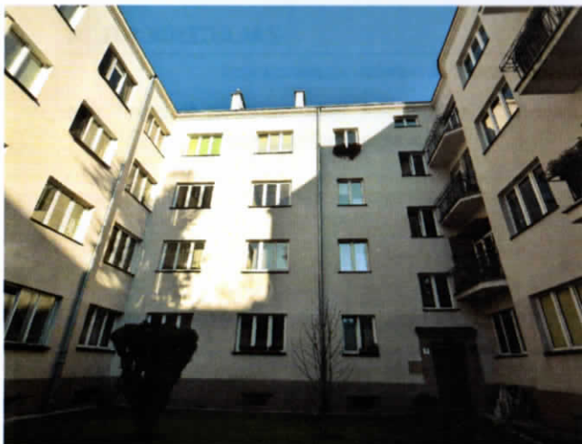
Fot. 7. Elewacja południowa budynku głównego przy klatce schodowej IV
