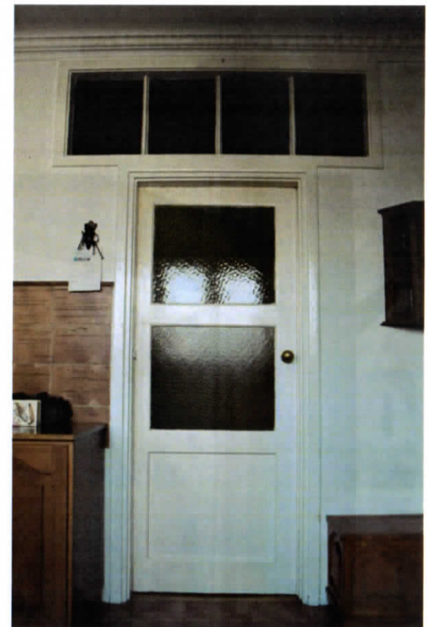
Fot. 9. Drzwi kuchenne z nadświetłem w mieszkaniu nr 64
