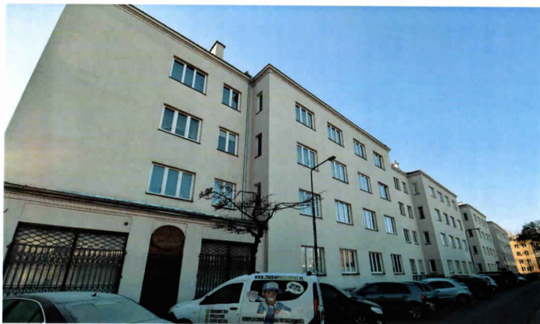
Fot. 3. Elewacja północna (przy ul. Hołówki), widok od strony wschodniej
