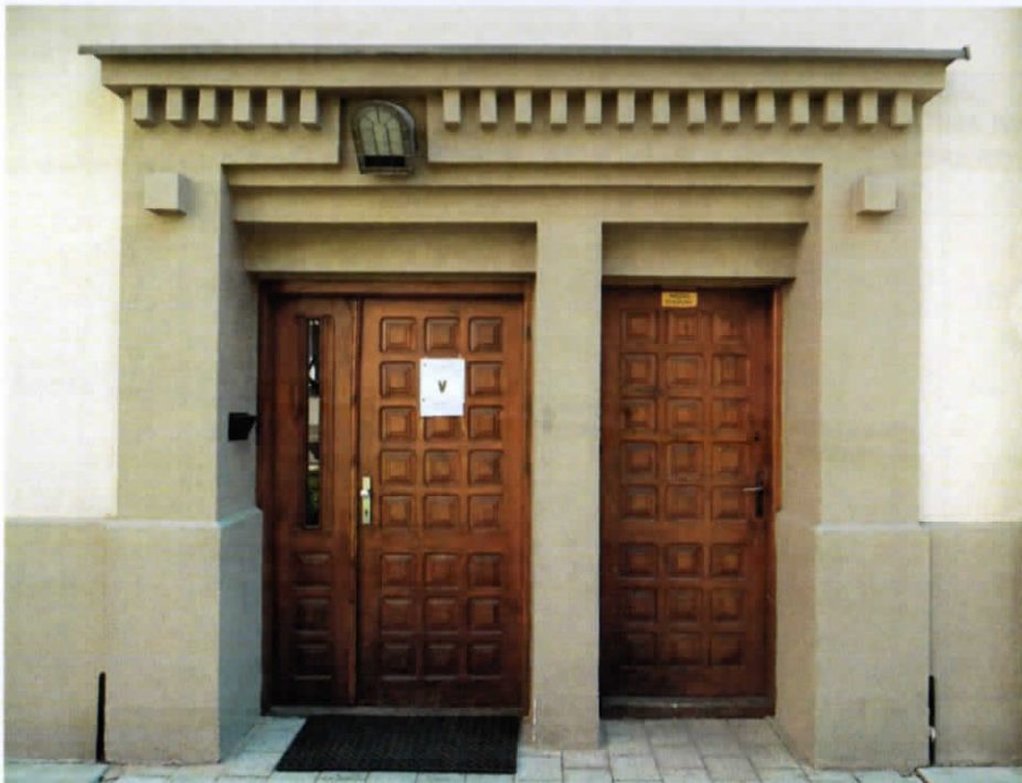
Fot. 6. Drzwi wejściowe do klatki schodowej nr V i do kotłowni (typowe drzwi przed wymianą w 2018 r.)
